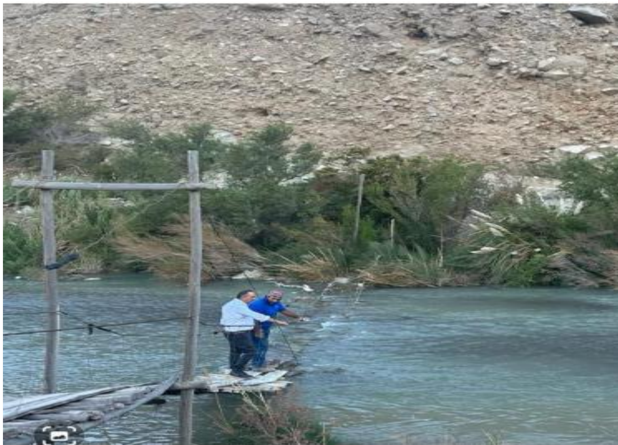
Representación de Senador Gahona en reparación de puente peatonal en Chapilca .
