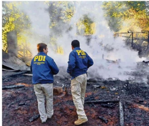
LA FISCALÍA INSTRUYÓ QUE LA BIPE DE LA PDI DE TEMUCO INVESTIGUE ESTE NUEVO ATAQUE INCENDIARIO.
